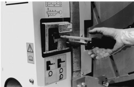
Abschalthebel in die Abschaltstellung ziehen ...
